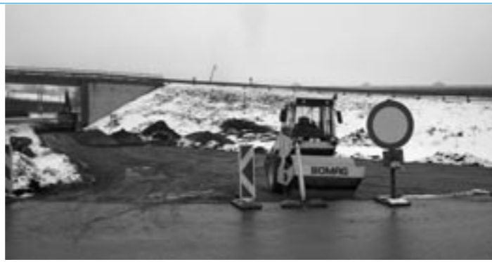
Industriezufahrt von Westen voll in Arbeit
