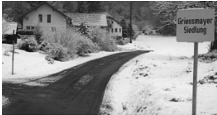
Asphaltierung Griessmayersiedlung abgeschlossen
